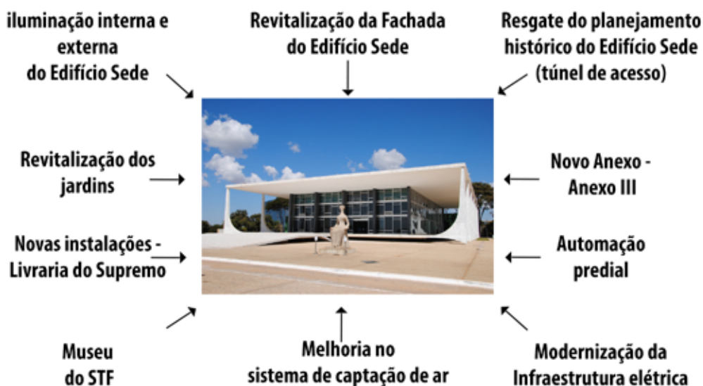
Obras e reformas prioritárias de 2019
